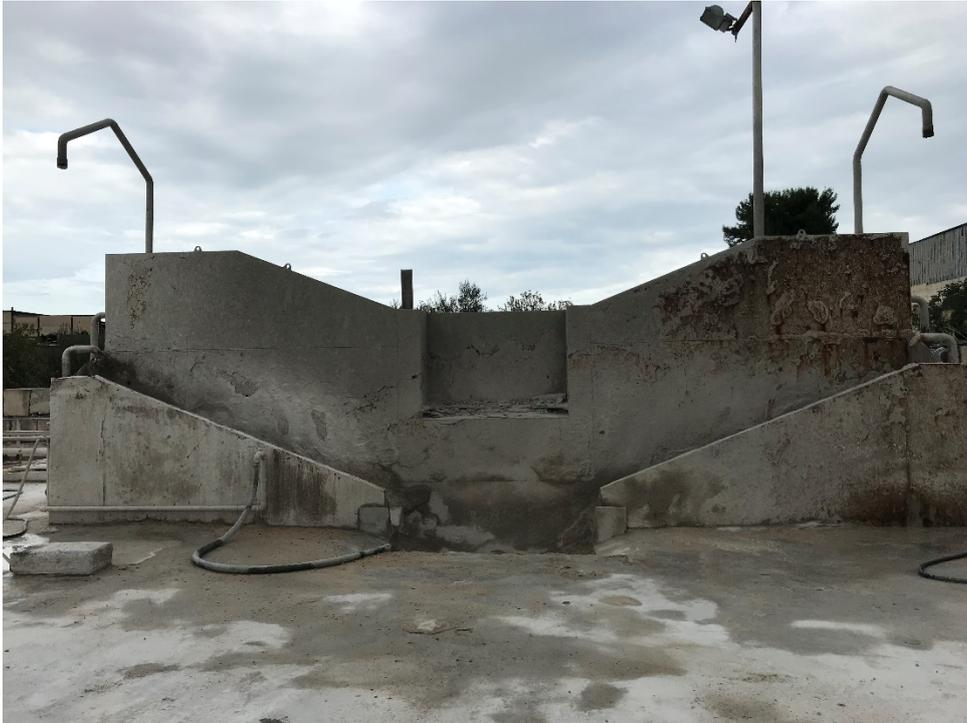
Figura 95 Impianto lavaggio betoniere
